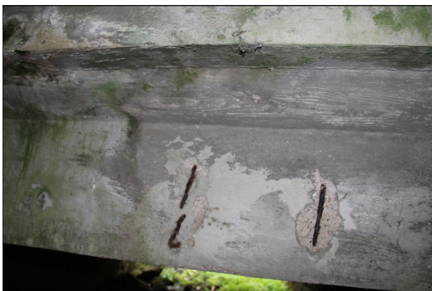
Koroze výztuže nosné konstrukce vlevo.
