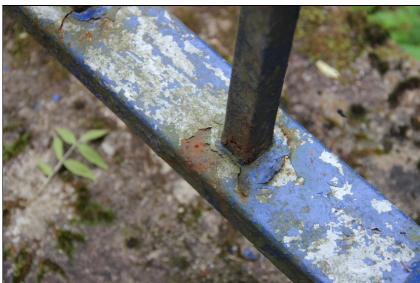
koroze zábradlí.
