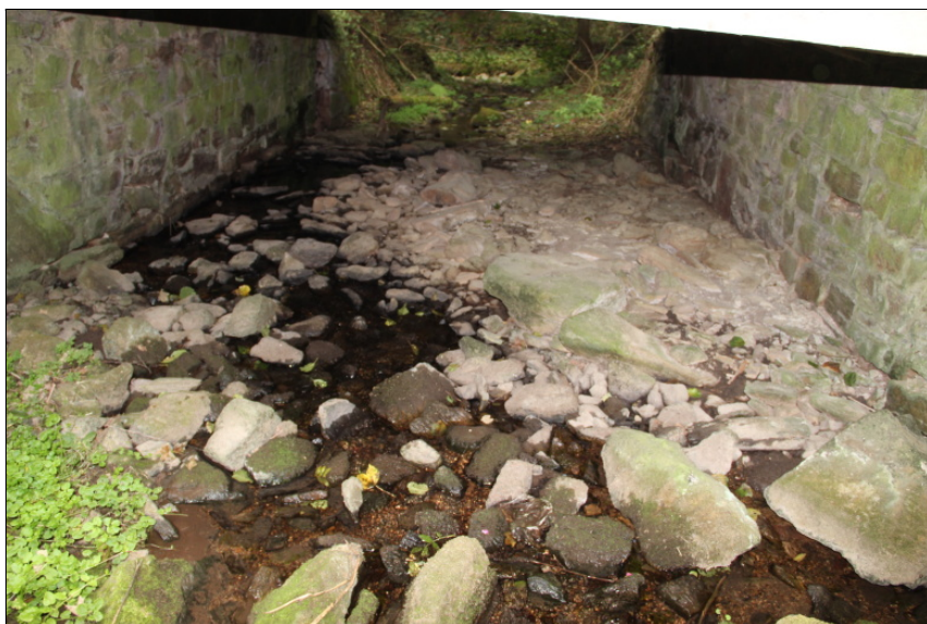
Vymleté opevnění koryta potoka.
