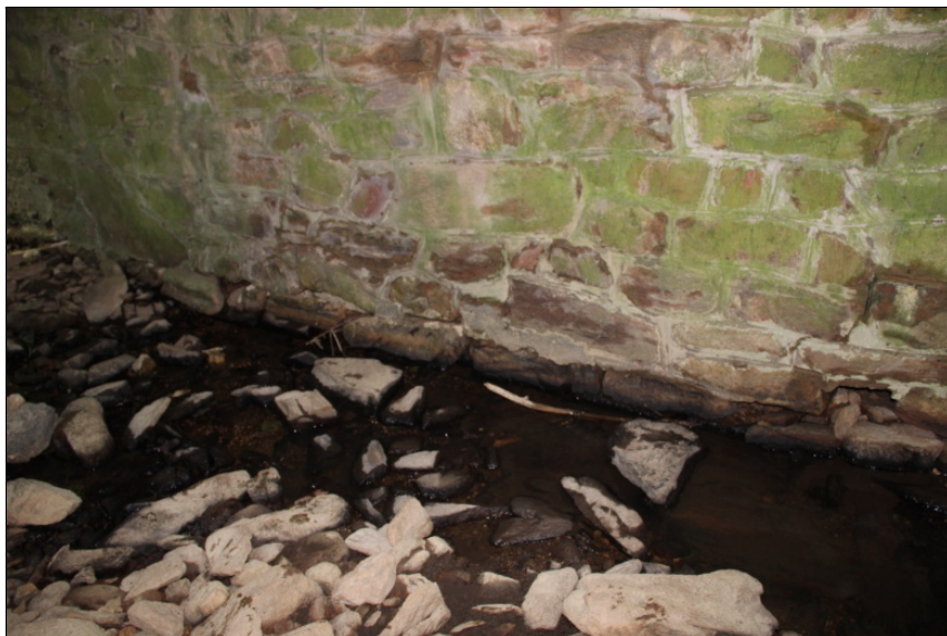
Uvolněné kameny ve zdivu a zatékání na OP1.
