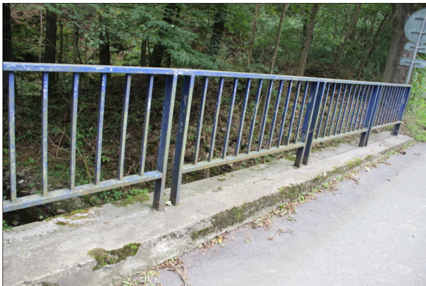
Levá římsa - koroze zábradlí a porost mechem.
