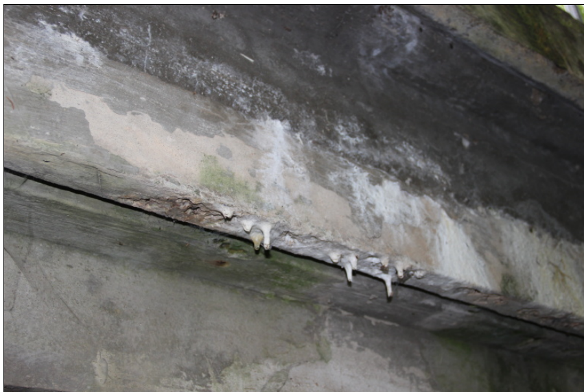
Zatékání, výluhy na nosné konstrukci vlevo.
