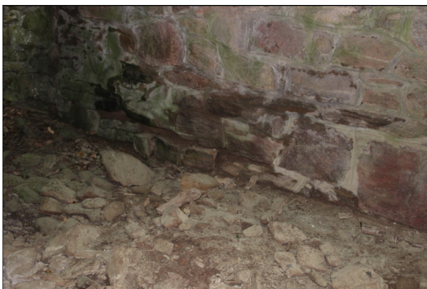
Uvolněné kameny ve zdivu, zatékání a podemílání zdiva na OP2.
